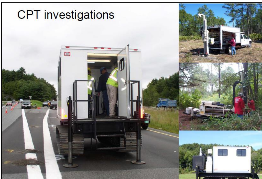
شکل ۷: استفاده از وانت جهت نصب جک هیدرولیکی CPT
