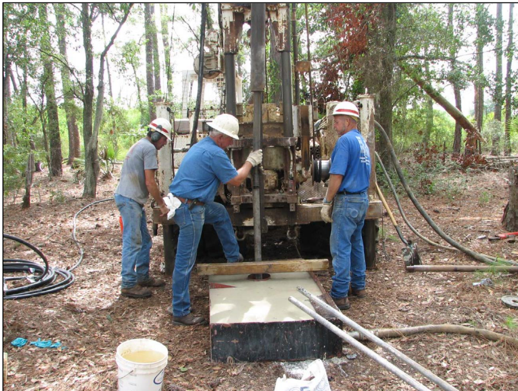
شکل ۶: نصب میله های رابط روی مخروط CPT
