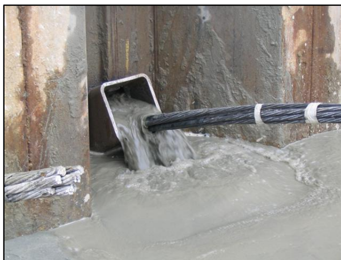
شکل ۱۶: تزریق گروت به حفره نصب انکر
