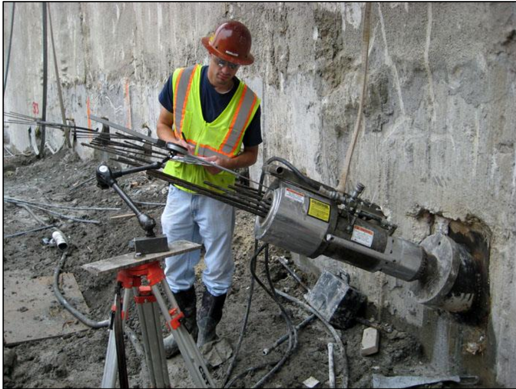
شکل ۷: اعمال نیروی پیش تنیدگی به المان کابلی
