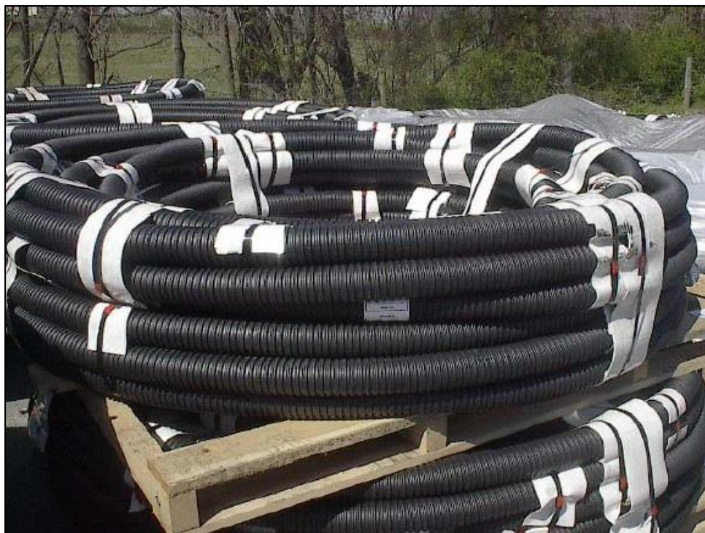
شکل ۱۳: تاندون‌های کابلی آماده شده
