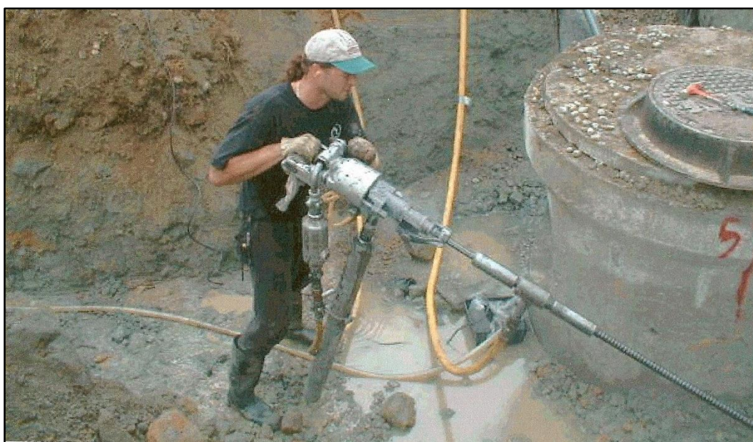
شکل ۶: جایگزاری المان میله‌ای در حفرة
