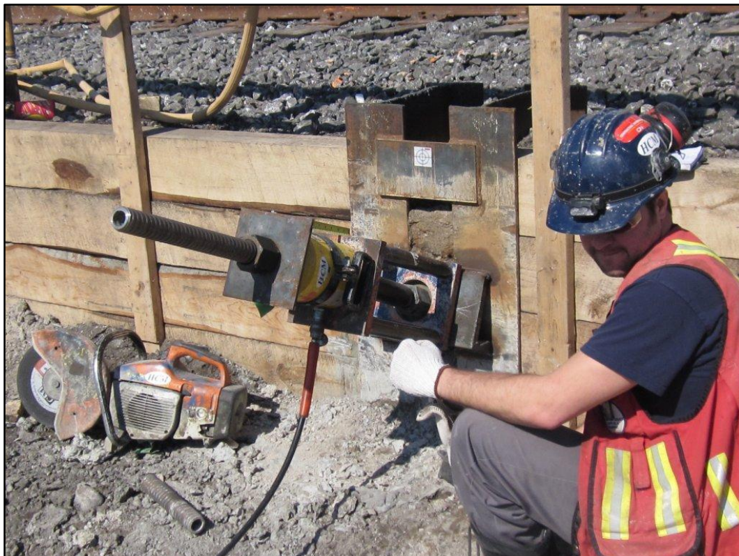
شکل ۸: اعمال نیروی پیش تنیدگی به المان میله‌ای
